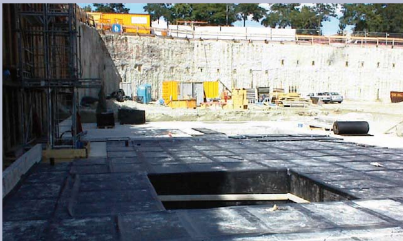
Verlegung von CIMAX
