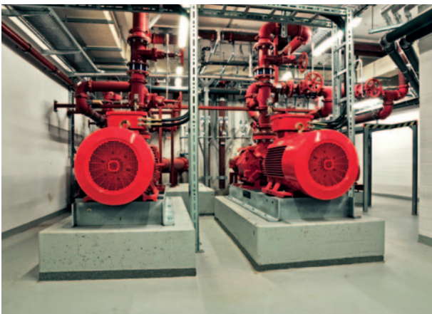
Nextower, Palaisquartier, Frankfurt a.M.: Schwingungsisolierung gebäudetechnischer Anlagen mit Regupol®
