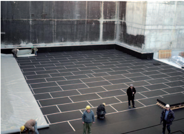
AGBU Verwaltungsgebäude, Jerewan, Armenien: Vollflächige Fundamententkopplung mit Regupol®
