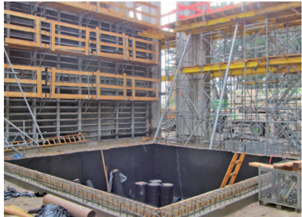
Flugsimulator Airbus A400M, Wunstorf: Vollflächige Maschinenfundamententkopplung mit Regupol®
