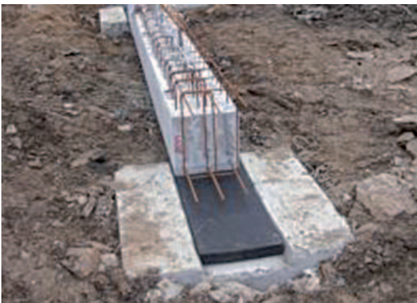
Punktueller elastische Lagerung auf den Einzelfundamenten mit Regufoam®
