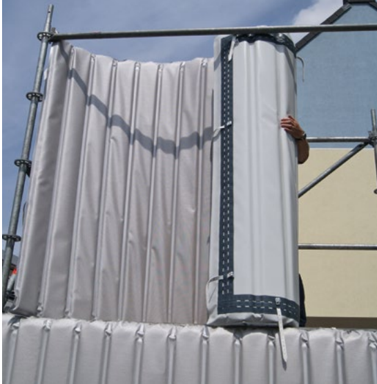
Bild 3: Ausrollen im Gerüstfeld
