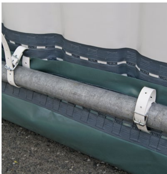
Bild 8: Befestigung Schleppstreifen an Gerüststange
