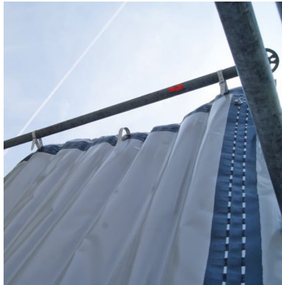
Bild 4: Befestigung und Ausrichten
