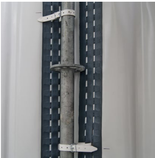
Bild 5: Ausrichtung, Befestigung am Gerüstpfosten
