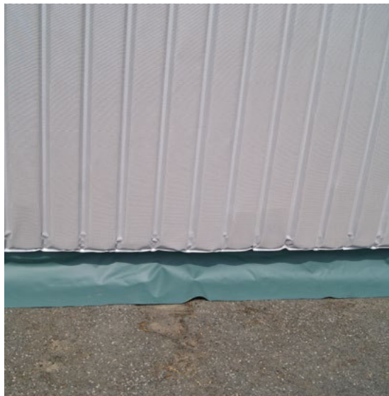
Bild 9: Schleppstreifen zur Lärmquelle ausziehen
