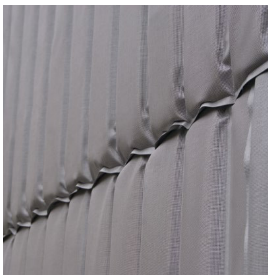
Bild 7: Vertikale Überlappung
