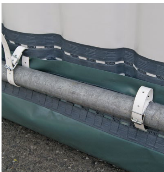
Bild 8: Befestigung Schleppstreifen an Gerüststange
