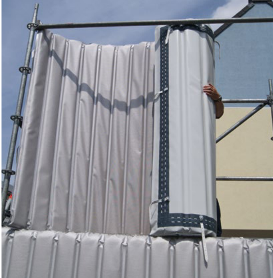
Bild 3: Ausrollen im Gerüstfeld
