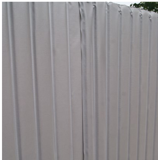
Bild 6: Ränder überlappen dicht
