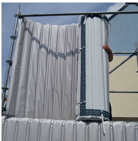
Ausrollen im Gerüstfeld
