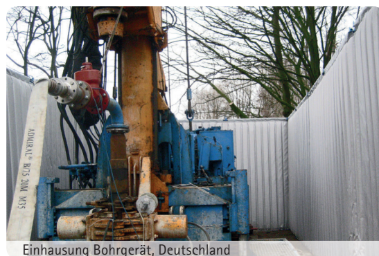
Einhausung Bohrgerät, Deutschland
