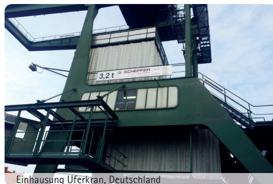
Einhausung Uferkran, Deutschland
