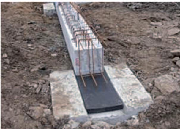
Punktuelle elastische Lagerung auf den Einzelfundamenten mit **Regufoam**®
