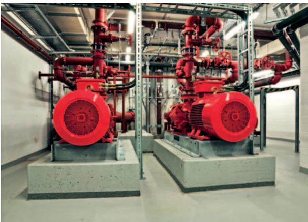
Nexttower, Palaisquartier, Frankfurt a.M.: Schwingungsisolierung gebäudetechnischer Anlagen mit **Regupol**®
